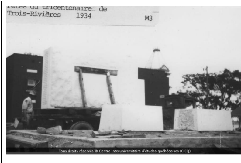
Installation du monument de La Violette par l'entrepreneur Laurent Paquin, 10 juillet 1934.
