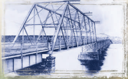
Pont sur la rivière Saint-Maurice Le quatrième pont sur la rivière Saint-Maurice, le premier en acier forgé au poids de 50 000 lb, est ouvert à la circulation en 1901. (Source: R.C. Thompson, un élève de l'école. Archives du Collège de Trois-Rivières, date inconnue de 1911)
