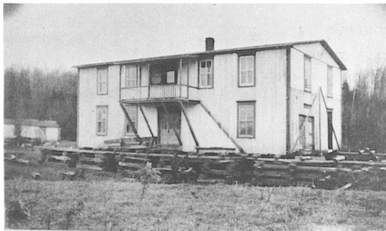
PH 16 Les "run" et les cages en place
