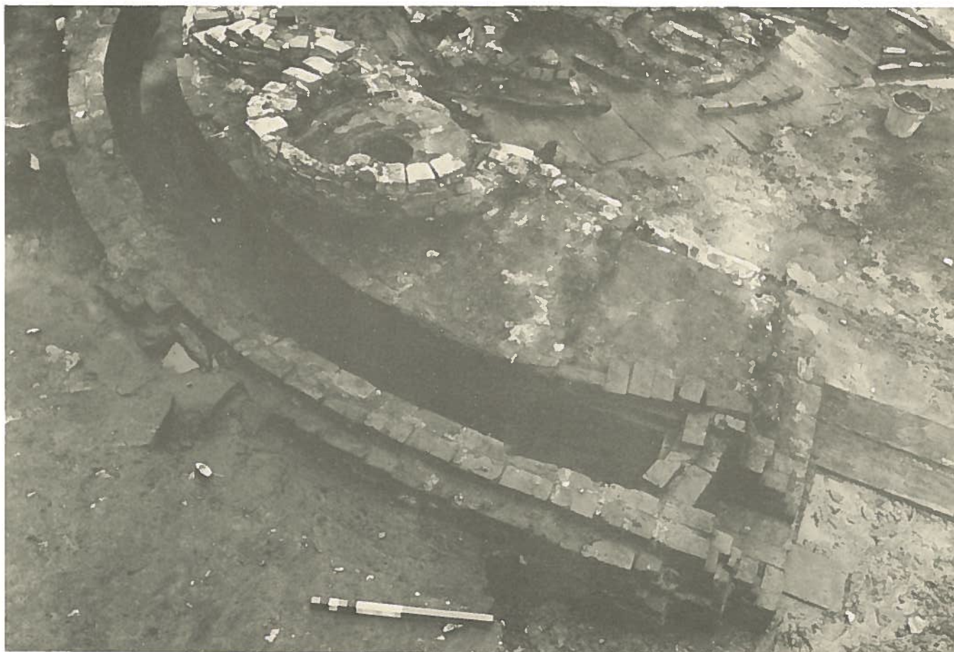
LA FONDERIE DE LA FORGE HAUTE.
