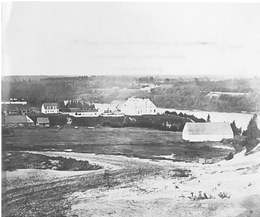
Les Forges du Saint-Maurice vues du plateau, au cours de la période McDougall. (PHOTO: COLLECTION ERIC SPRENGER, MONTRÉAL, CANADA).
