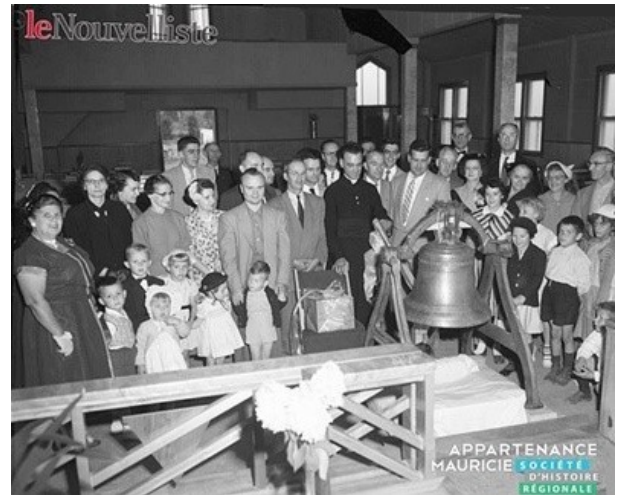
75 : installation de la cloche, 1954, N14796-001.
