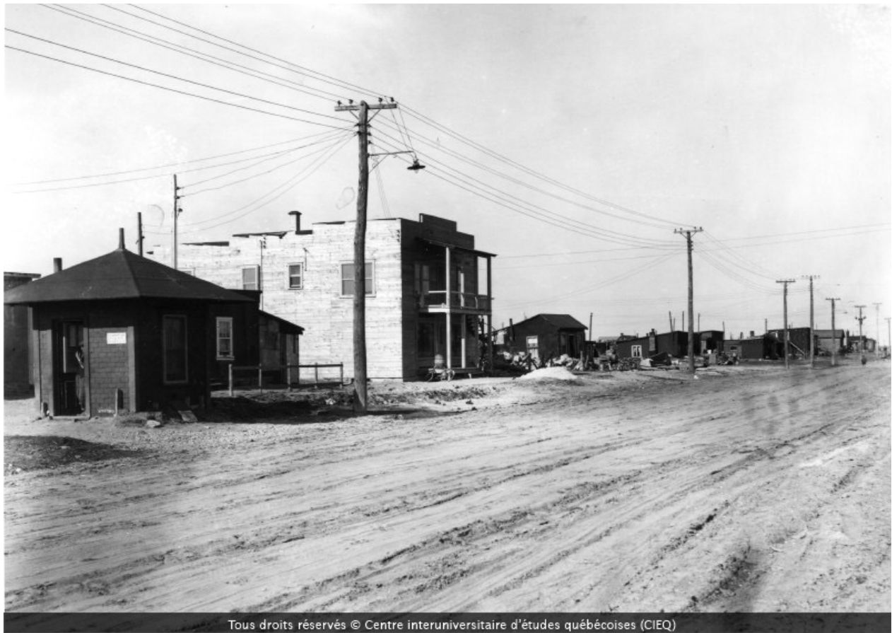
131 : rue du quartier après qu'on eut installé l'électricité, CIEQ.
