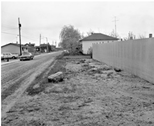
103 : 1301, 9e Rue et mur de la cour arrière, 1967, BAnQ, P30, S2, 7417.
