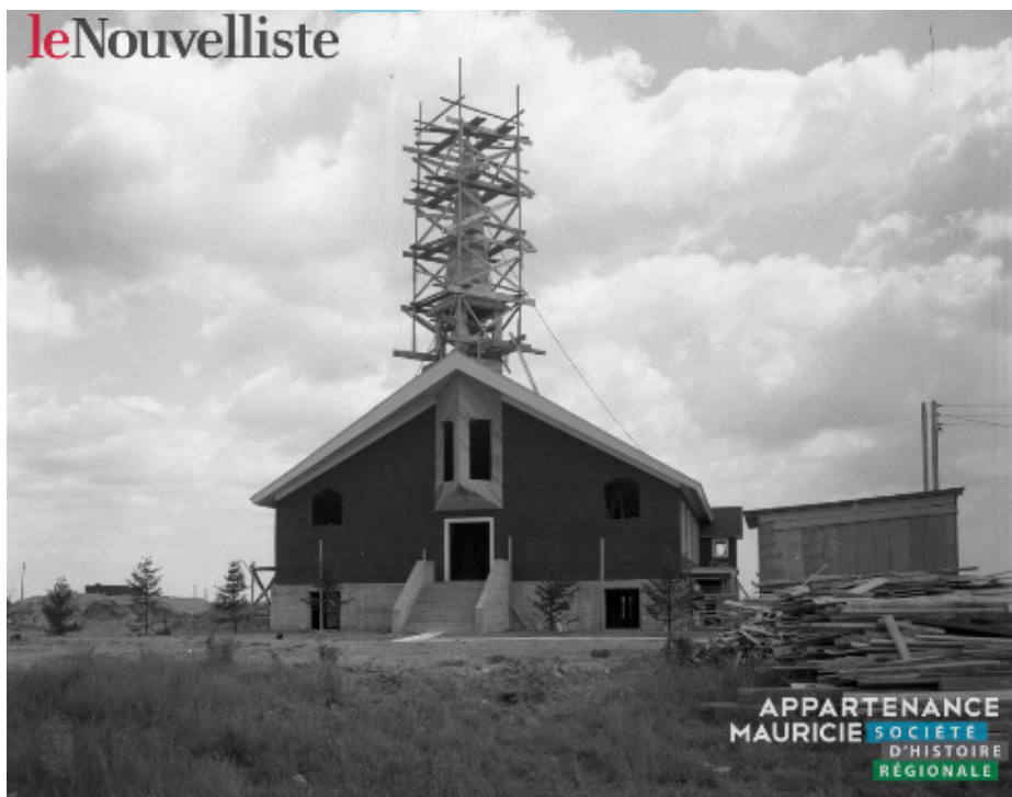
76 : église Ste-Thérèse en construction, 1954, N14797-001.
