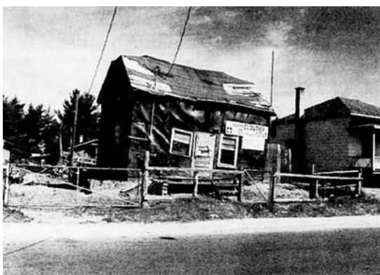
108: ferme de M. Cloutier, 16e Rue, Nouvelliste, 21 septembre 1982,
