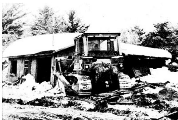
109 : démolition des bâtiments, 16e Rue, Nouvelliste, 21 septembre 1982, .
