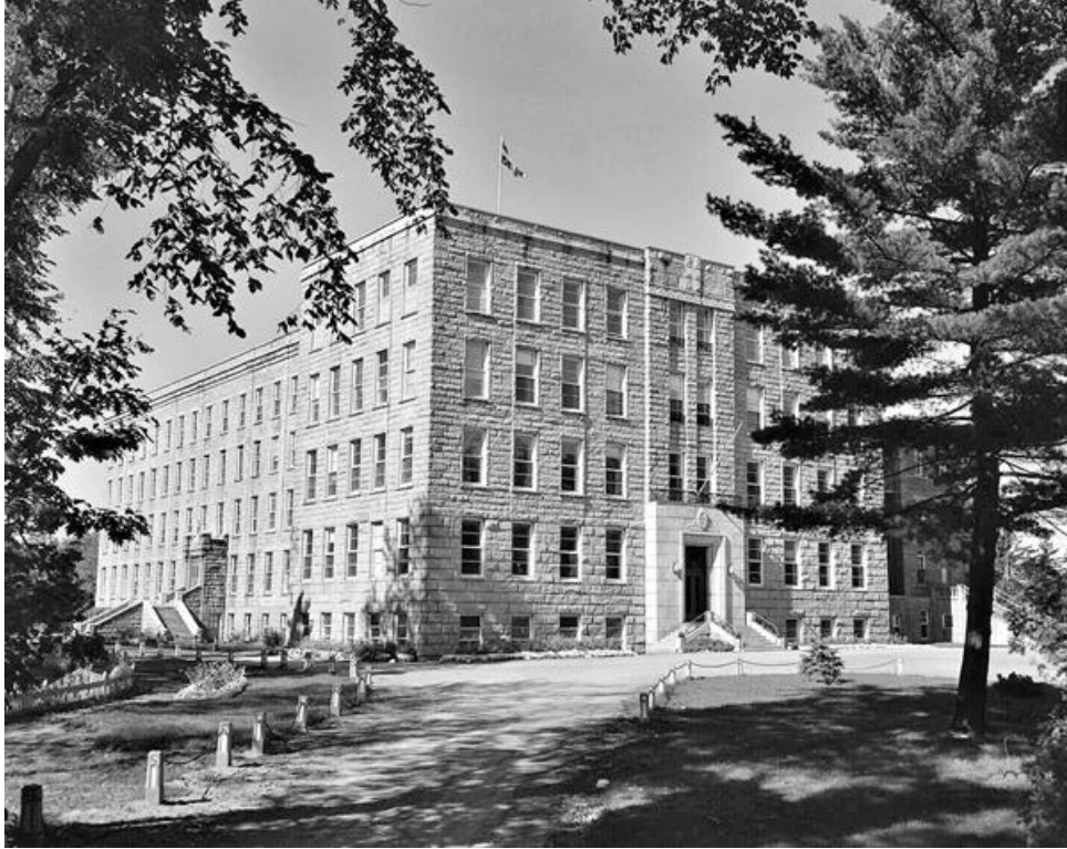
156. 1953, le scholasticat, crédit photo Omer Beaudoin, Archives nationales à Québec, fonds du Min. de la Culture et des Communications, E6,S7,SS1,D2,P96864
